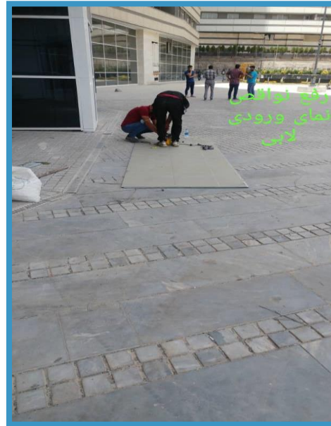
نصب درب های لابی شرقی و غربی
