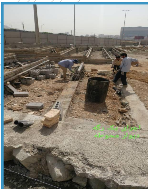
نصب درب های لابی
