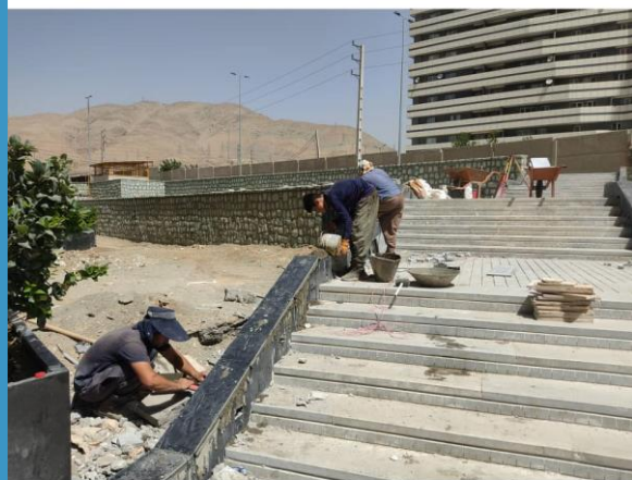
اجرای سنگ گرانیت راه پله محوطه شمالی
