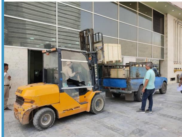
ورود تجهیزات آتش نشانی به کارگاه
