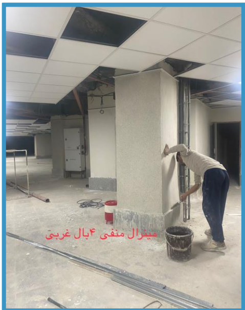
اجرای ساپورت جعبه اطفا ط ۳-
