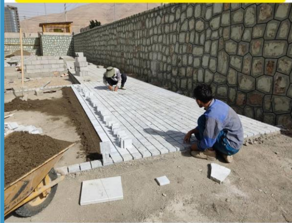
اجرای سنگ کیوب محوطه شمال غربی
