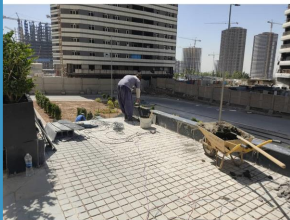
تکمیل سنگ کاری راه پله محوطه جنوبی برج
