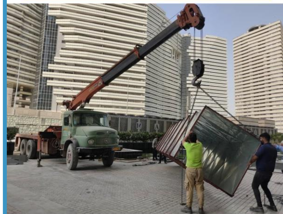
نصب کانالهای اگزاست مونتاژ شده ضلع شمالی
