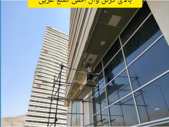
تکمیل درزگیری و بتونه سقف کاذب بالای کرتن وال افقی ضلع غربی
