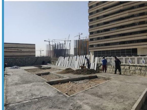
محوطه سازی ضلع شمالی برج
