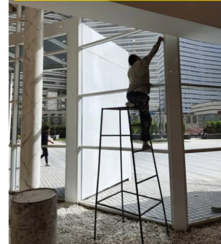
درزگیری و اجرای چسب سیلیکون بین لامل و ورقهای دو پوسته ای لابی
