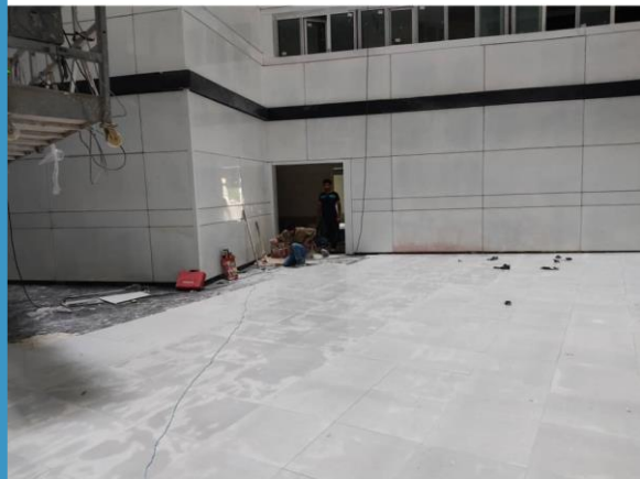
اجرای سرامیک کف و وید پال شرقی
