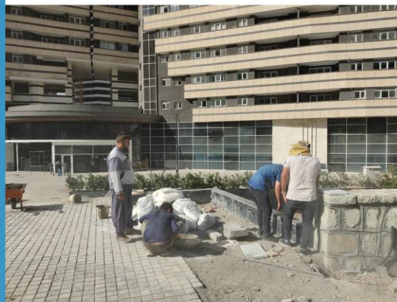
اجرای سنگ کاری راه پله شمالی
