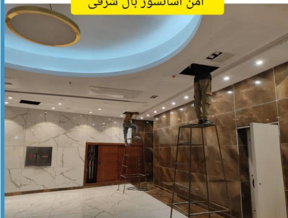
تکمیل کابل کشی سقف لابی امن آسانسور پال شرقی
