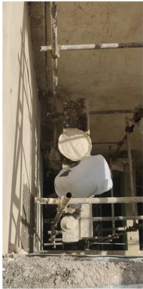
سیمان کاری دیوار نورگیر موتورخانه طبقه منفی یک
