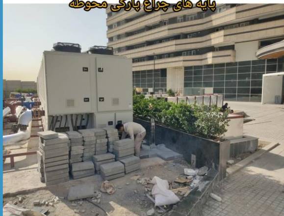
گرگیزی جدول جهت نصب پایه های چراغ پارکی محوطه
