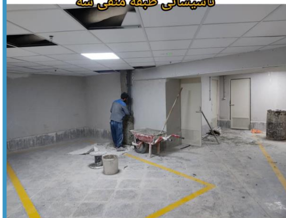
سیمان کاری روی لوله های تاسیساتی طبقه منفی سه
