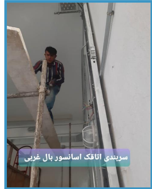
اجرای لوله اطفاء ط ۳-
