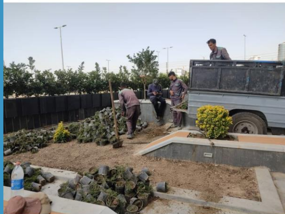
ادامه کاشت فضای سبز محوطه جنوبی برج
