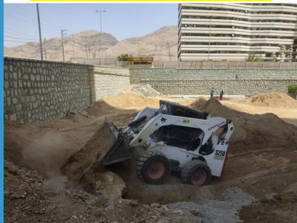
اجرای خاک باغچه محوطه غربی برج
