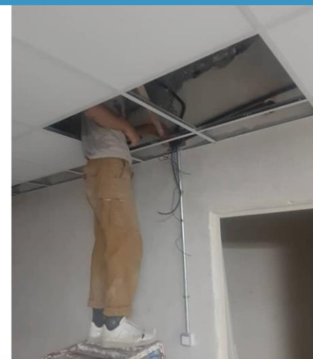
نصب و سر بندی کلید روکار طبقه منفی دو
