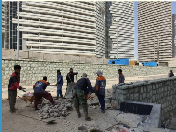
اجرای محوطه سازی ضلع شمالی برج
