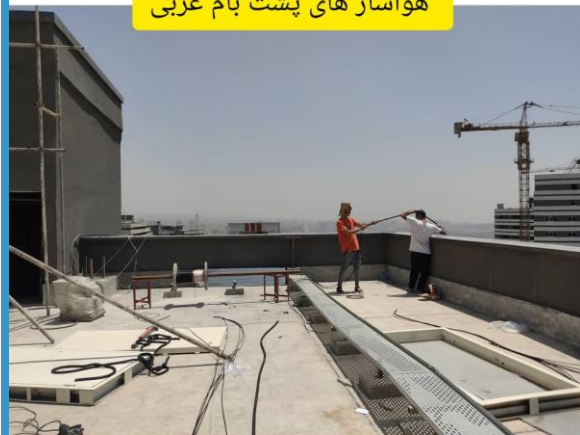
کابل کشی جهت راه اندازی هواساز های پشت بام غربی
