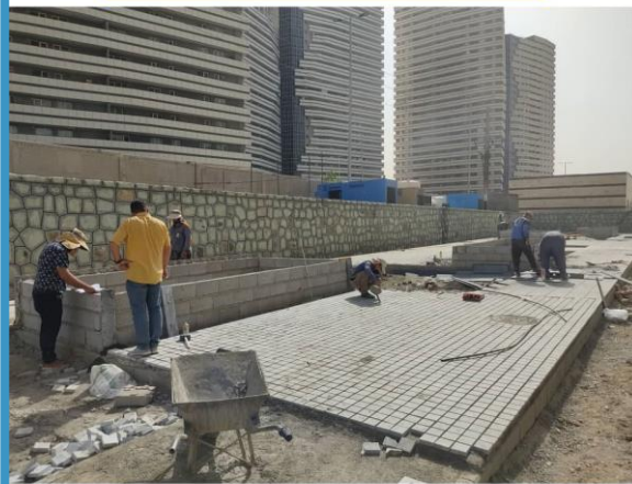
محوطه سازی ضلع شمال شرقی برج
