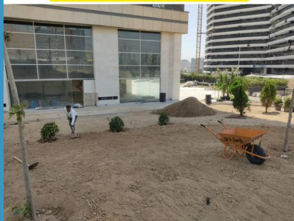
اجرای فضای سبز محوطه غربی
