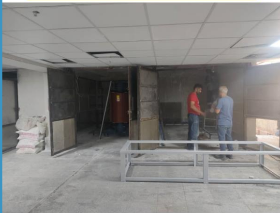
تکمیل عملیات اتاق ترانس برق منفی یک
