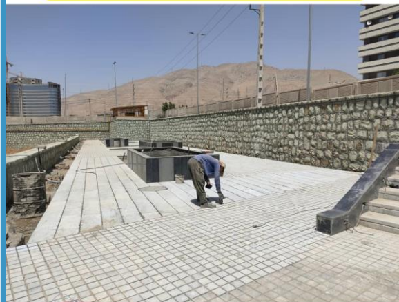
دوغاب ریزی سنگ کیوب محوطه شمال
