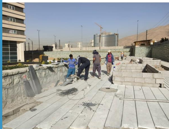
اجرای محوطه سازی ضلع شمال غربی
