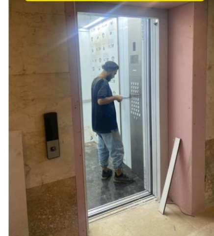
نصب پوشش محافظ mdf کابین آسانسور سه تایی غربی
