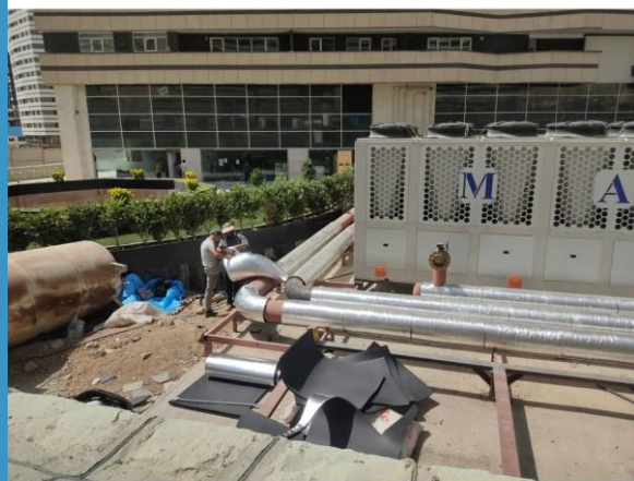
اجرای عایق دور لوله های چیلر
