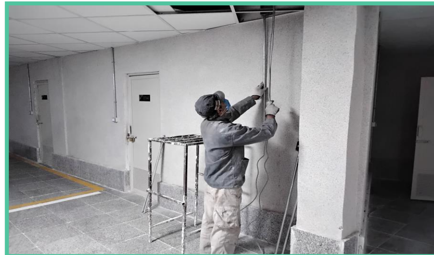
اجرای لوله گذاری برق جهت راه اندازی اعلام حریق طبقه منفی دو
