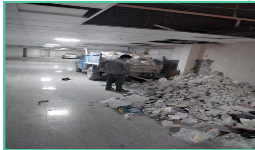
اجرای جمع آوری نخاله از طبقه منفی سه
