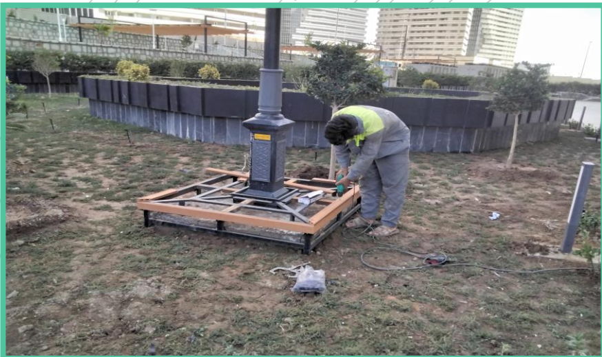
اجرای ساخت نیمکت پیرامونی تیر چراغ برق محوطه شمالی
