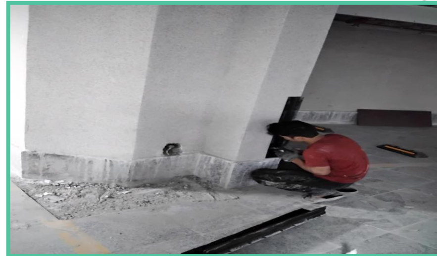
اجرای نصب ضربه گیر پارکینگ منفی چهار
