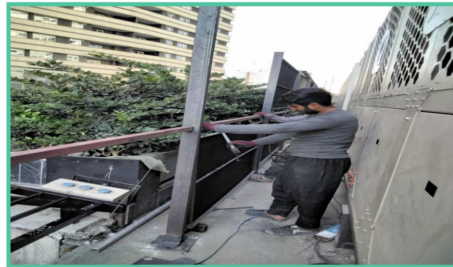
ادامه اجرای نصب حفاظ پیرامونی چیلرها محوطه شمالی
