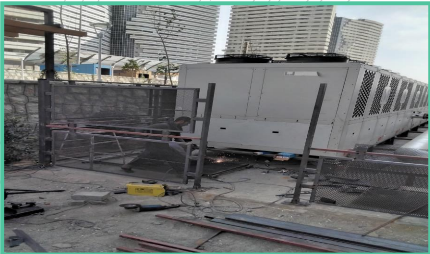
اجرای حفاظ پیرامونی چیلرها ضلع شمالی
