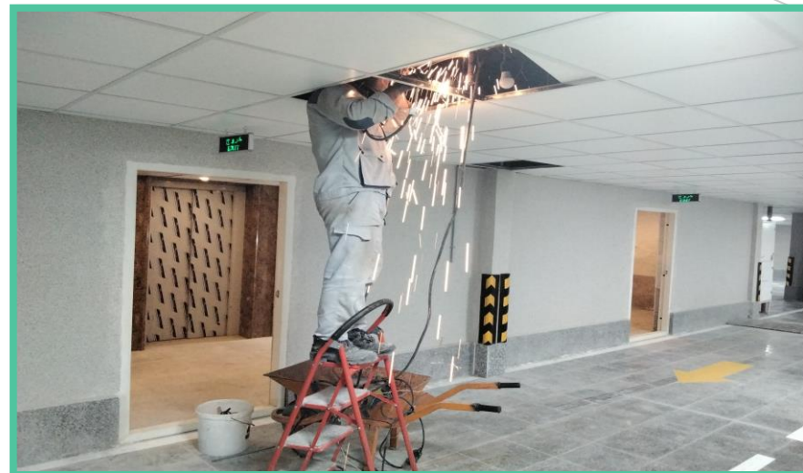
اجرای اصلاح لوله اسپرینکلر طبقه منفی سه
