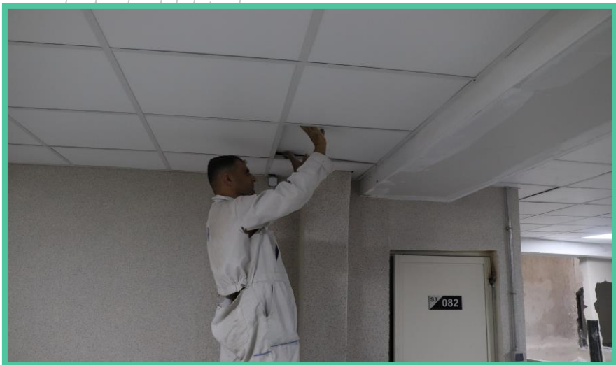
اجرای رفع نقص سقف کاذب طبقه منفی سه
