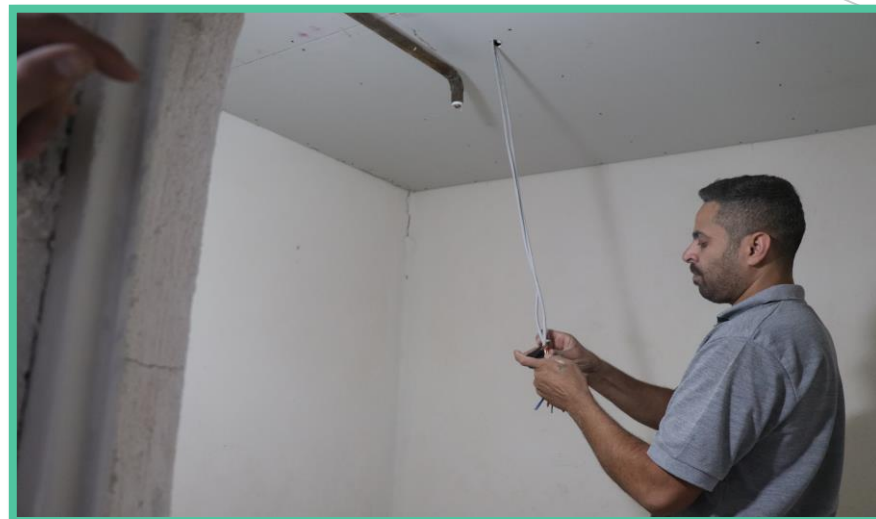
اجرای نصب دنتور اعلام حریق انباری های طبقه منفی چهار
