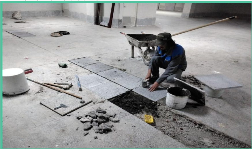
اجرای لکه گیری سنگ کف پارکینگ منفی یک
