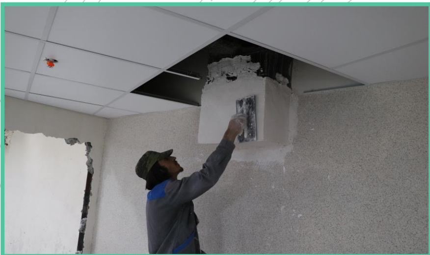
اجرای گچ کاری باکس ستون ها طبقه منفی چهار
