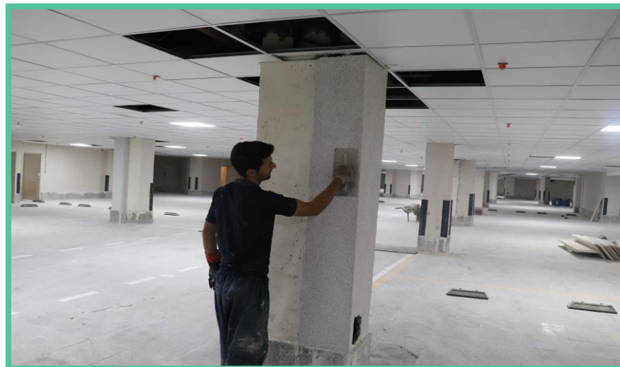
اجرای رفع نقص پوشش مینرال طبقه منفی چهار
