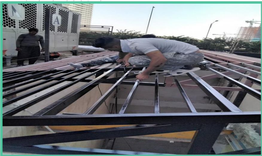
اجرای رنگ آمیزی نورگیر موتورخانه ضلع شمالی
