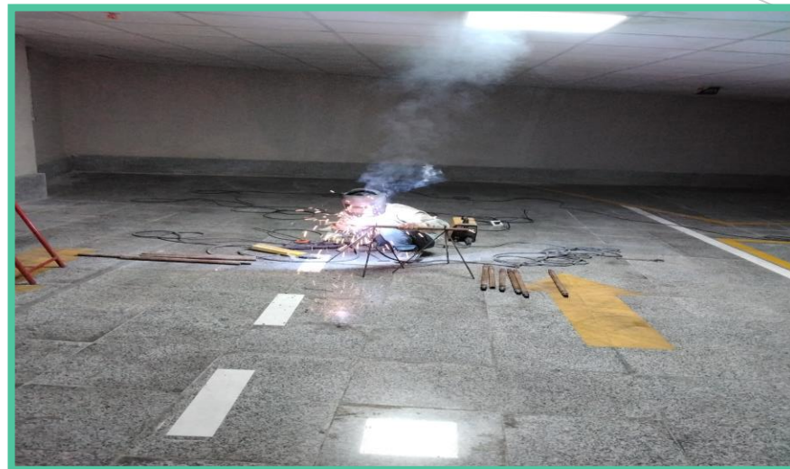
اجرای نصب ضربه گیر پارکینگ منفی چهار
