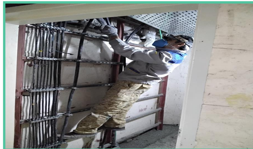
اجرای کابل کشی سیم ارت طبقه منفی یک
