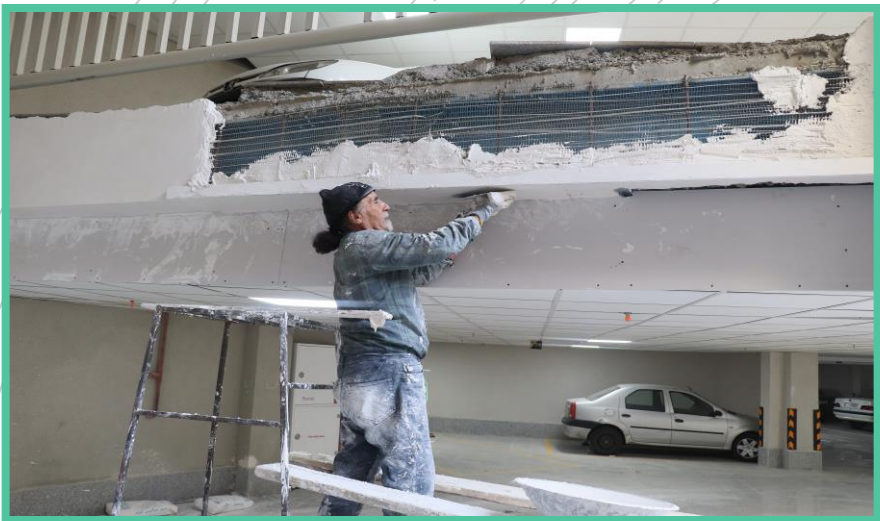
اجرای گچ کاری رپم منفی دو
