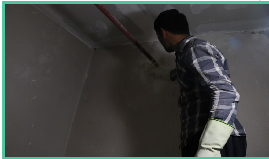
اجرای دودبندی انباری ها طبقه منفی سه
