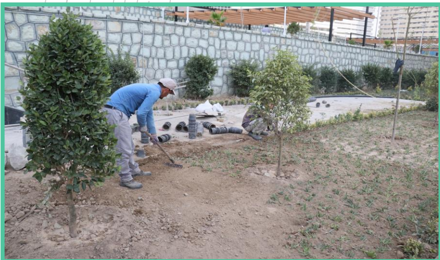
اجرای فضای سبز محوطه شمال غربی
