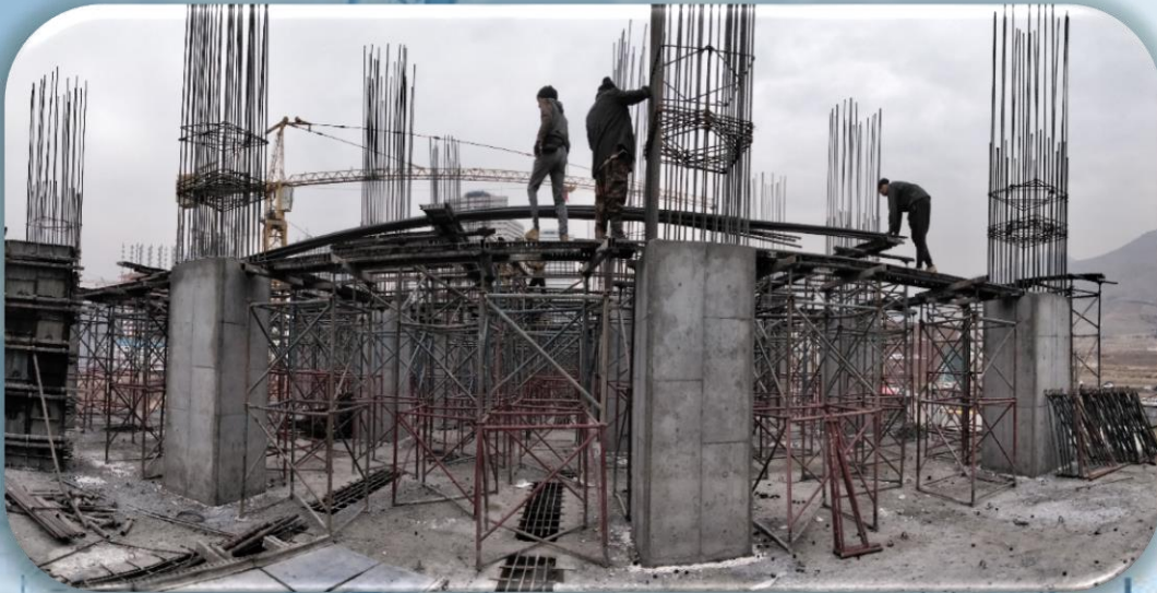
تیرهای سقف طبقه ۳+ زون ۲
