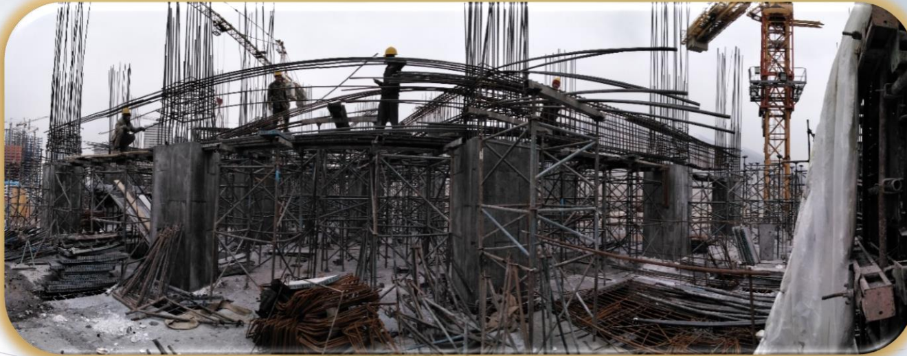
تیرهای سقف طبقه ۵+ (کف ۶+) بال شرقی
