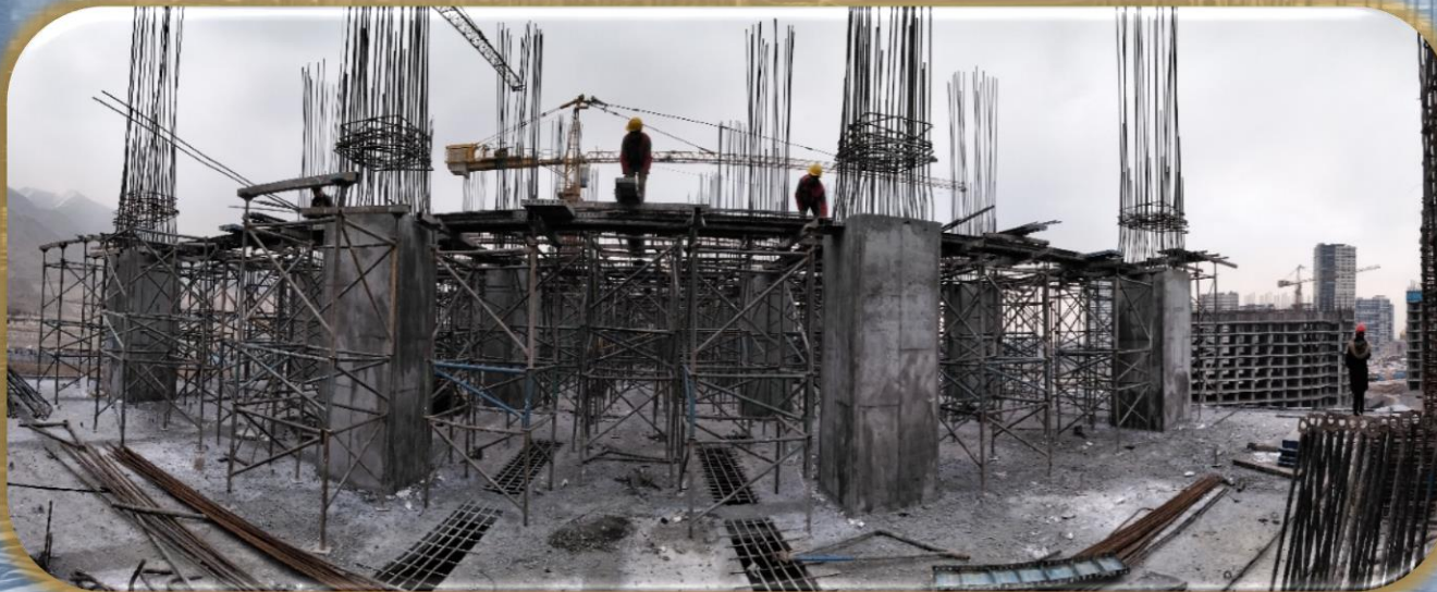
تیرهای سقف طبقه ۵+ (کف ۶+) هسته مرکزی و بال غربی
