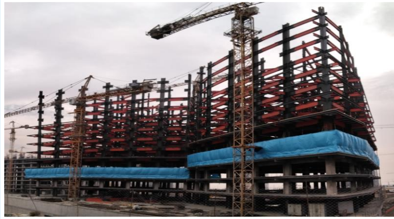
ضلع شمال مورخ ۱۴۰۱/۰۹/۰۱
