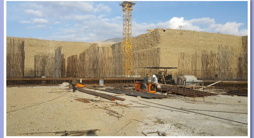
اجرای آرماتور بندی قطعه E
