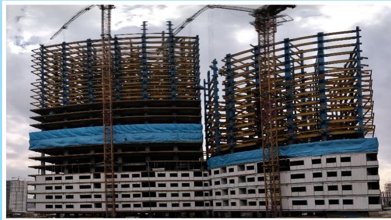
ضلع شمال مورخ ۱۴۰۱/۰۸/۳۰
