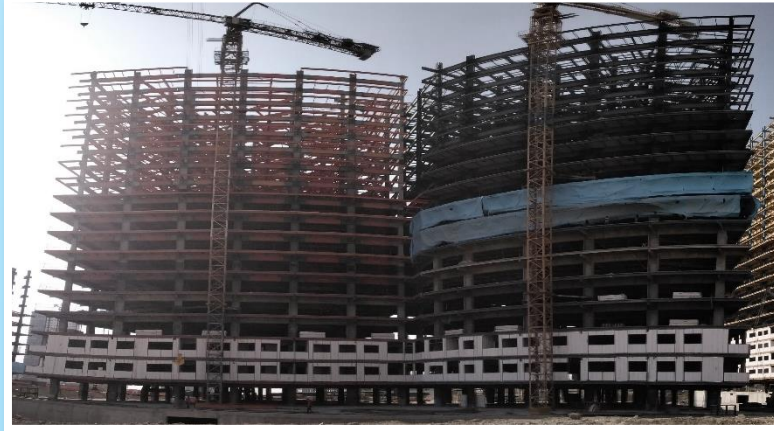
ضلع شمال مورخ ۱۴۰۱/۰۸/۰۱
