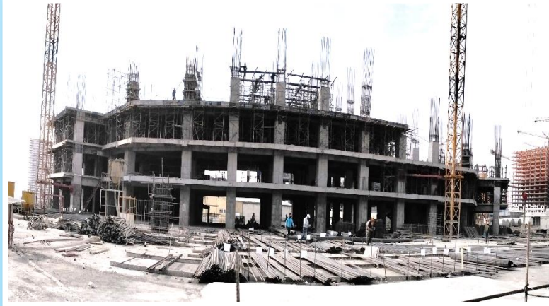
ضلع شمال مورخ ۱۴۰۱/۰۸/۰۱
