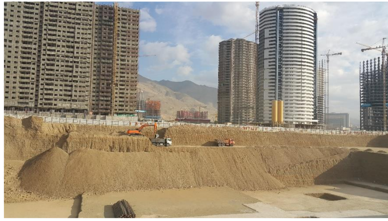
اجرای گودبرداری قطعه B
