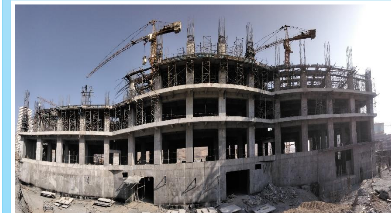
ضلع جنوب مورخ ۱۴۰۱/۰۷/۳۰
