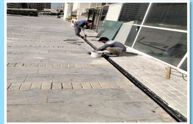
اجرای نظافت گاتر پلت فرم محوطه جنوبی
