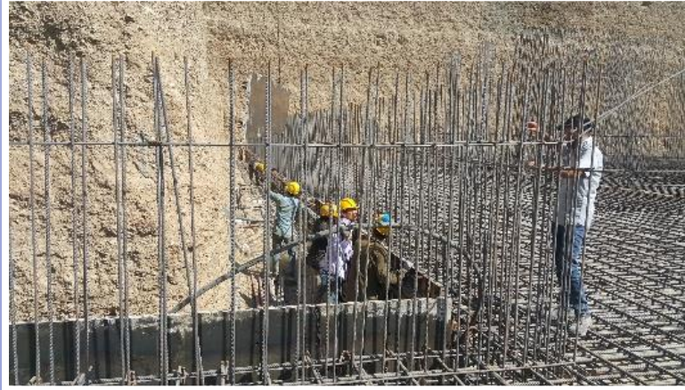
اجرای آرماتوربندی قطعه E
