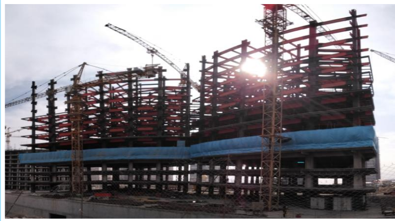
ضلع شمال مورخ ۱۴۰۱/۰۹/۳۰
