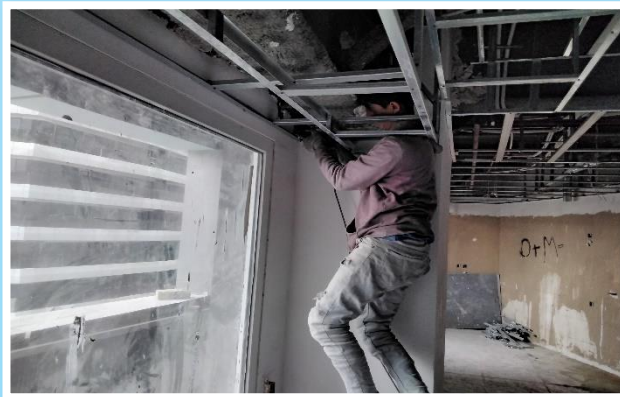
اجرای زیرسازی کناف سقف واحدها
