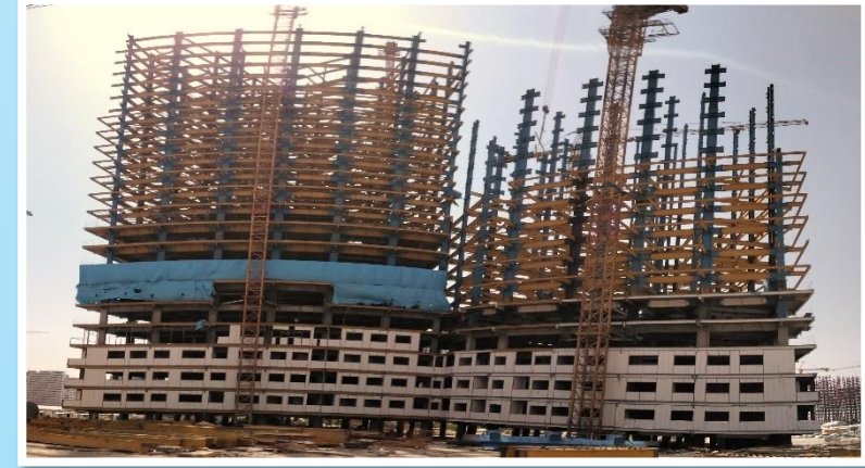
ضلع شمال مورخ ۱۴۰۱/۰۷/۰۱
