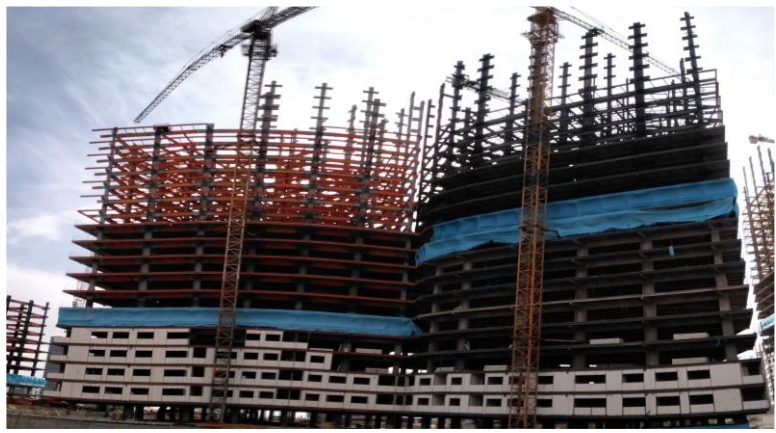
ضلع شمال مورخ ۱۴۰۱/۰۹/۳۰
