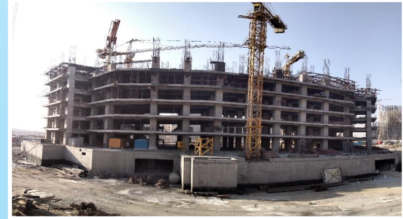
ضلع شمال مورخ ۱۴۰۱/۰۷/۰۱
