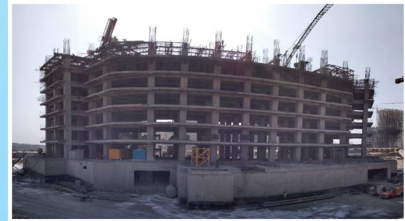
ضلع شمال مورخ ۱۴۰۱/۰۷/۳۰
