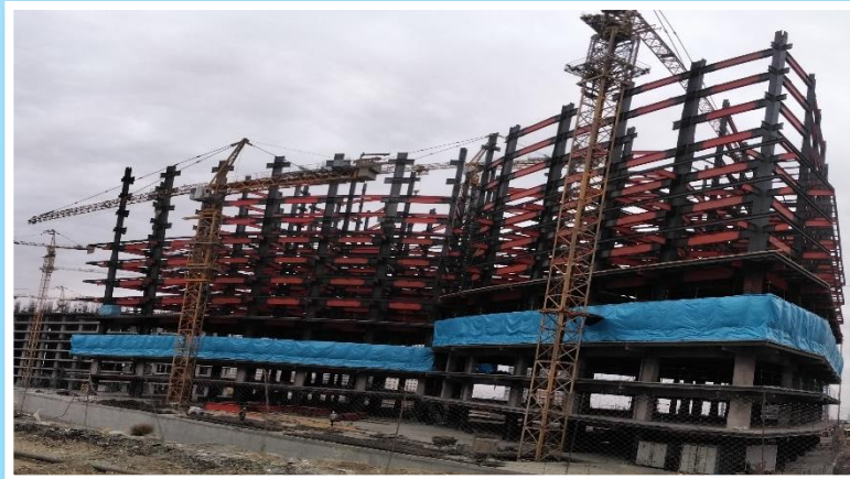
ضلع شمال مورخ ۱۴۰۱/۰۸/۳۰
