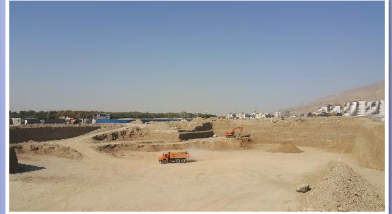
اجرای گودبرداری قطعه D
