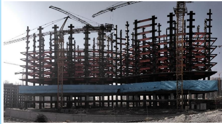
ضلع شمال مورخ ۱۴۰۱/۰۸/۰۱
