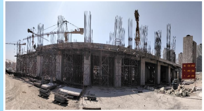
ضلع شمال مورخ ۱۴۰۱/۰۷/۰۱
