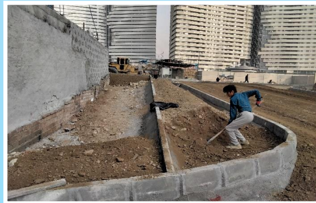
اجرای زیرسازی پیاده روی و فضای سبز ضلع شرقی
