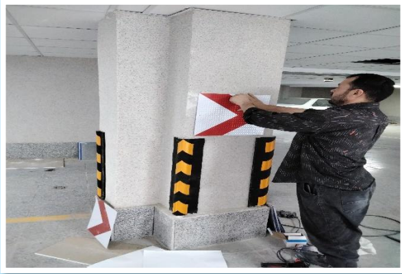
اجرای نصب علائم راهنمایی پارکینگ منفی دو
