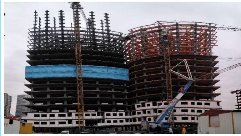
ضلع جنوب مورخ ۱۴۰۱/۰۸/۳۰
