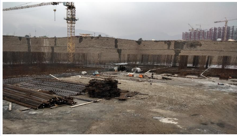
اجرای آرماتور بندی قطعه E
