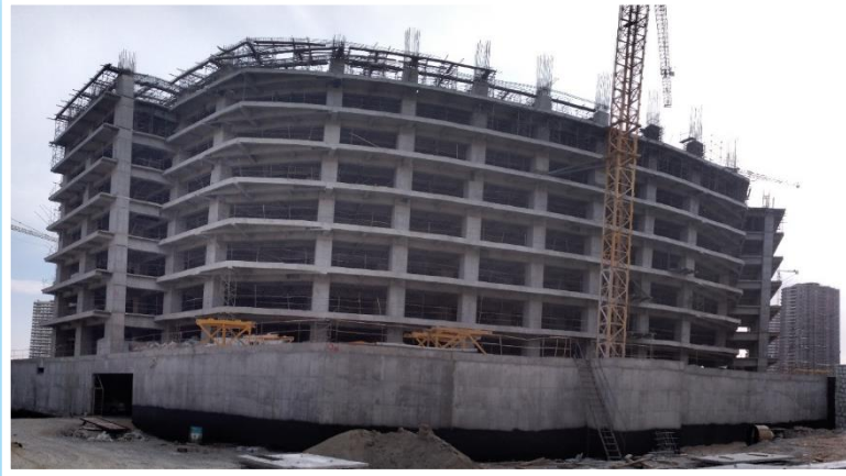
ضلع شمال مورخ ۱۴۰۱/۰۸/۰۱
