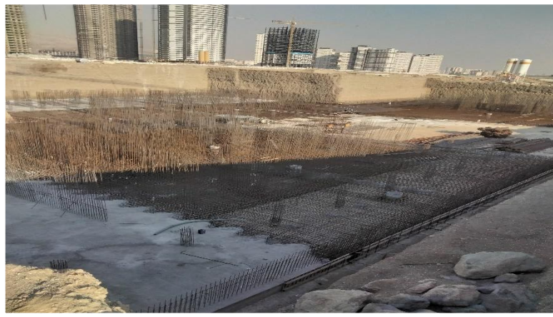
اجرای بتن ریزی فونداسیون قطعه E
