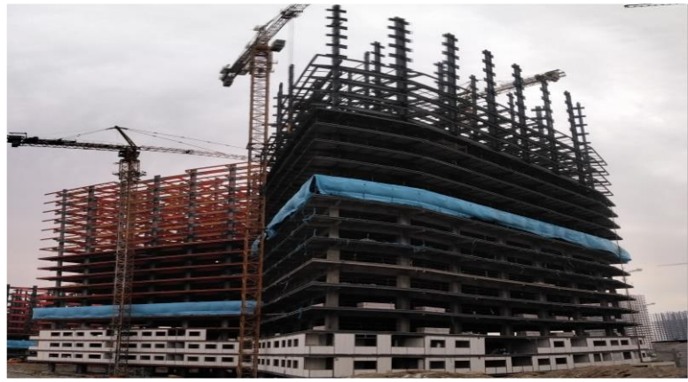
ضلع شمال مورخ ۱۴۰۱/۰۹/۰۱
