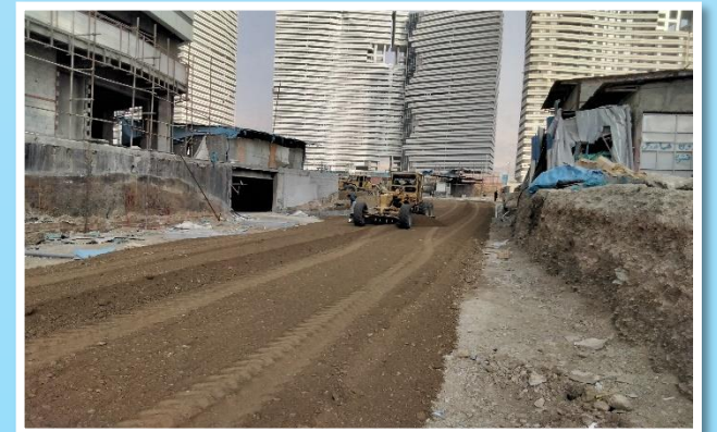
اجرای تسطیح، رگلاژ و کامپکت ضلع شرقی
