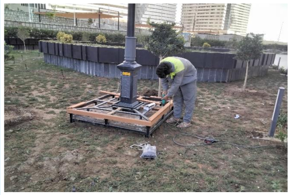
اجرای ساخت نیمکت پیرامونی تیر چراغ برق محوطه شمالی
