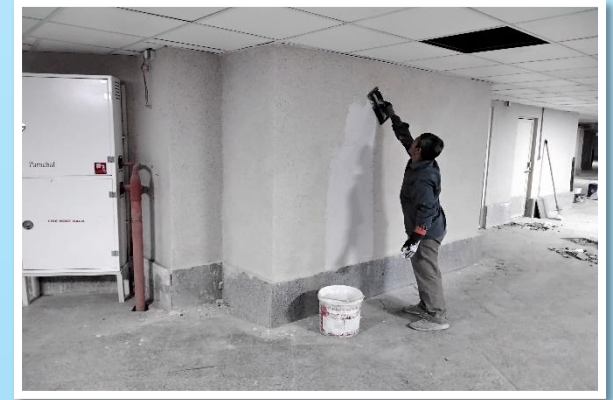
اجرای رفع نفص پوشش مینرال از پارکینگ منفی یک
