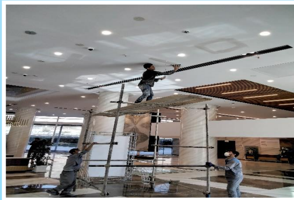
اجرای رفع نقص و رنگ آمیزی سقف لابی مرکزی
