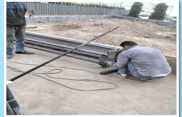
اجرای ساخت و نصب نیمکت زمین بازی محوطه شمالی
