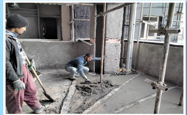
اجرای بتن ریزی موتورخانه میانی
