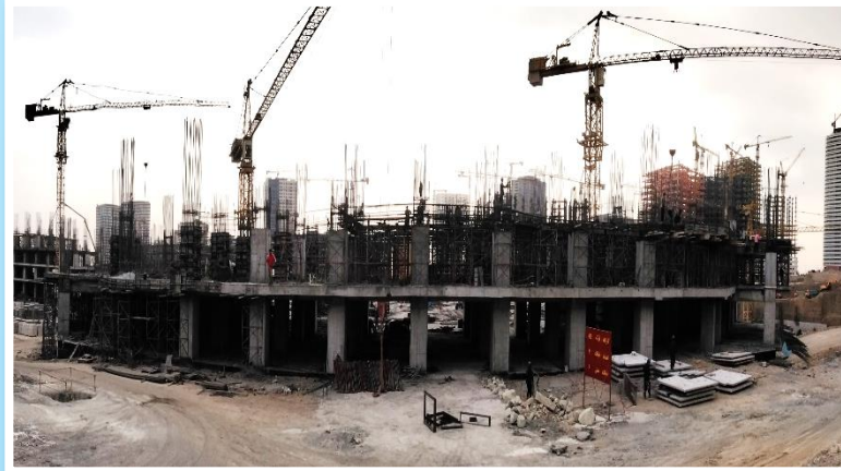
ضلع شمال مورخ ۱۴۰۱/۰۸/۰۱
