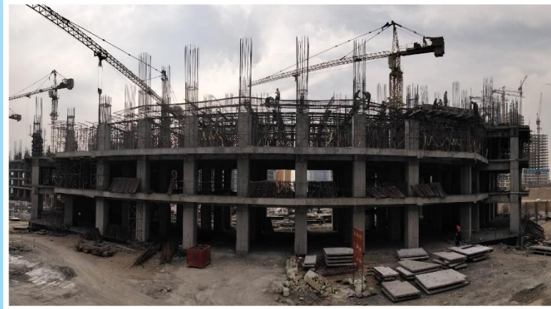
ضلع شمال مورخ ۱۴۰۱/۰۸/۳۰
