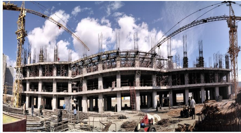
ضلع جنوب مورخ ۱۴۰۱/۰۹/۰۱
