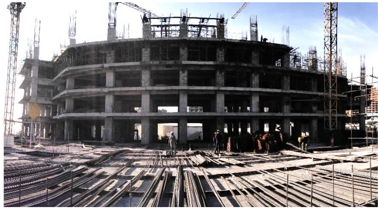
ضلع شمال مورخ ۱۴۰۱/۰۹/۰۱
