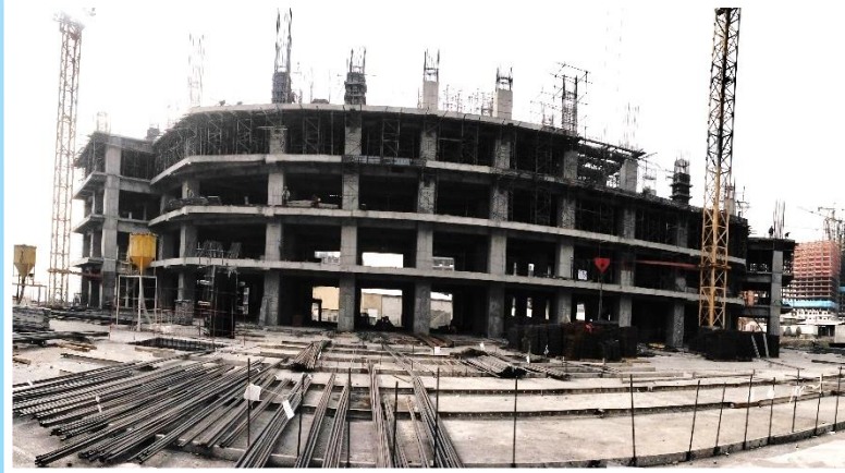
ضلع شمال مورخ ۱۴۰۱/۰۸/۳۰
