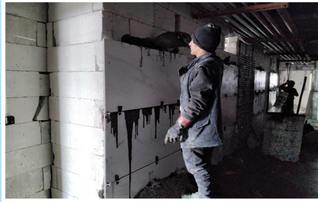
اجرای کاشی کاری راهروها
