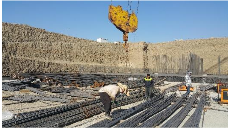
اجرای آرماتوربندی قطعه E
