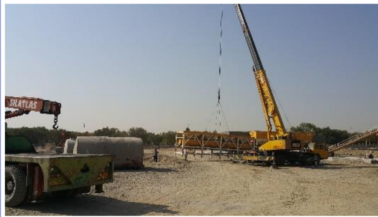
اجرای نصب پچینگ
