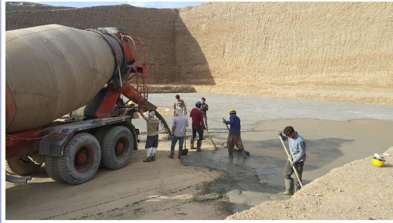
اجرای بتن ریزی مگر قطعه F
