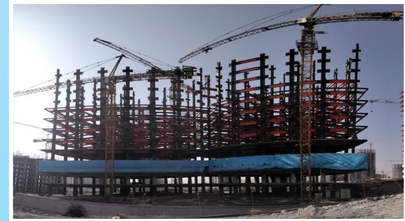
ضلع شمال مورخ ۱۴۰۱/۰۷/۳۰
