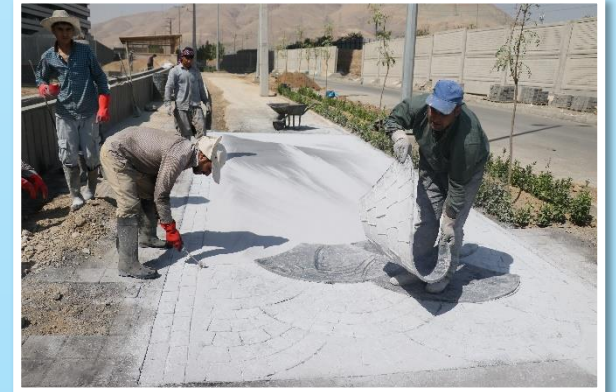
اجرای پیاده رو محوطه شمالی
