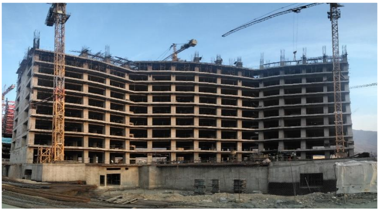
ضلع جنوب مورخ ۱۴۰۱/۰۹/۳۰
