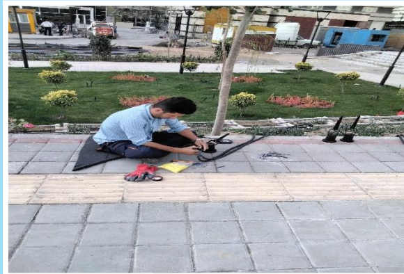
اجرای نصب فلاور باکس محوطه شمالی
