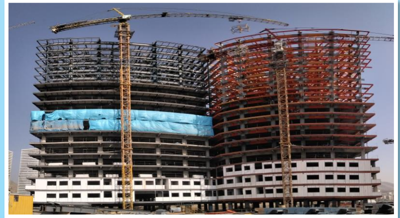
ضلع جنوب مورخ ۱۴۰۱/۰۷/۳۰
