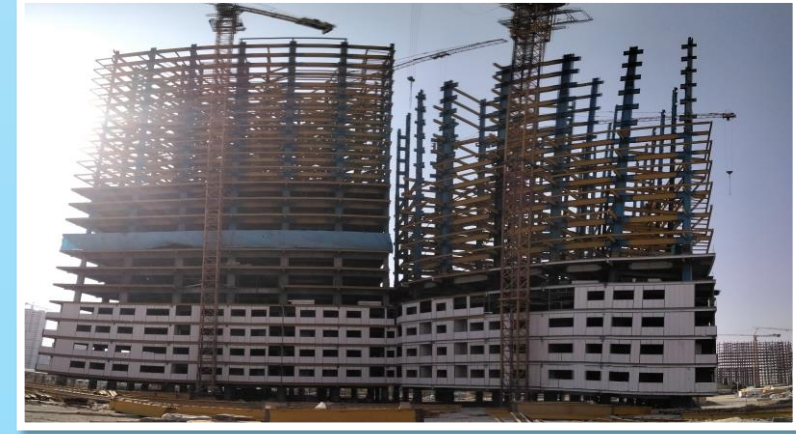
ضلع شمال مورخ ۱۴۰۱/۰۷/۳۰
