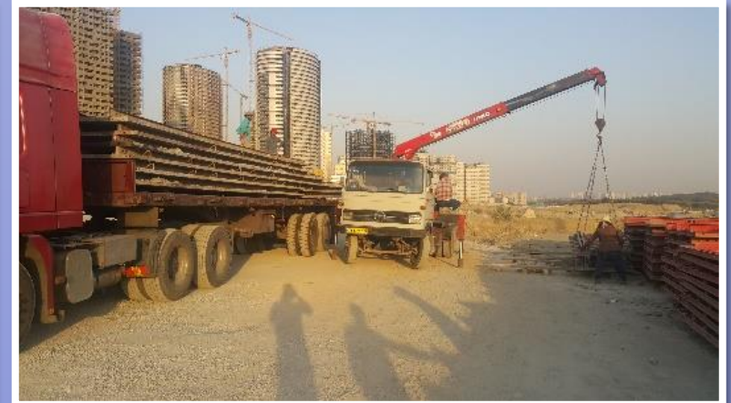
ورود قالب تونلی به کارگاه
