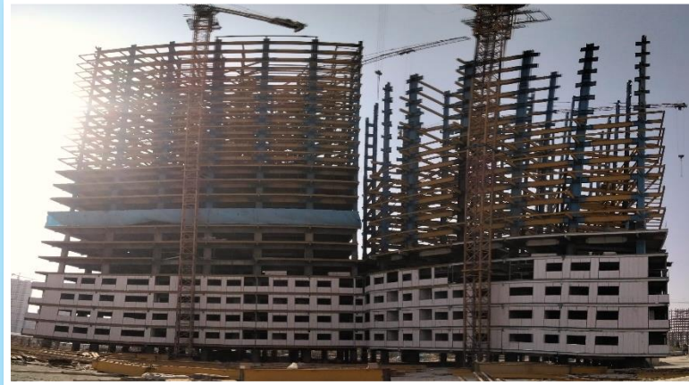
ضلع شمال مورخ ۱۴۰۱/۰۸/۰۱
