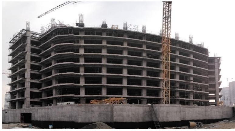
ضلع شمال مورخ ۱۴۰۱/۰۹/۰۱
