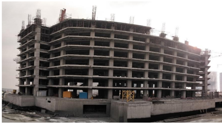
ضلع شمال مورخ ۱۴۰۱/۰۹/۰۱
