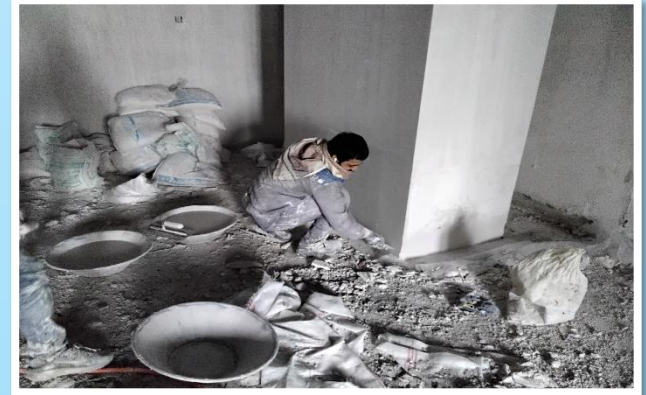
اجرای گچ کاری و سفید کاری واحدها
