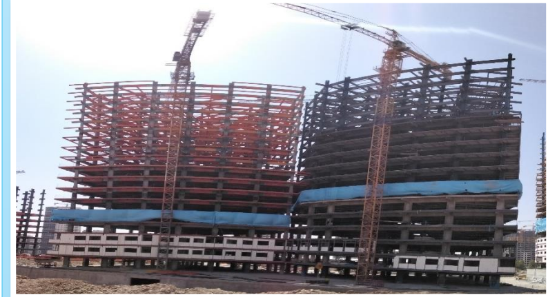
ضلع شمال مورخ ۱۴۰۱/۰۷/۰۱
