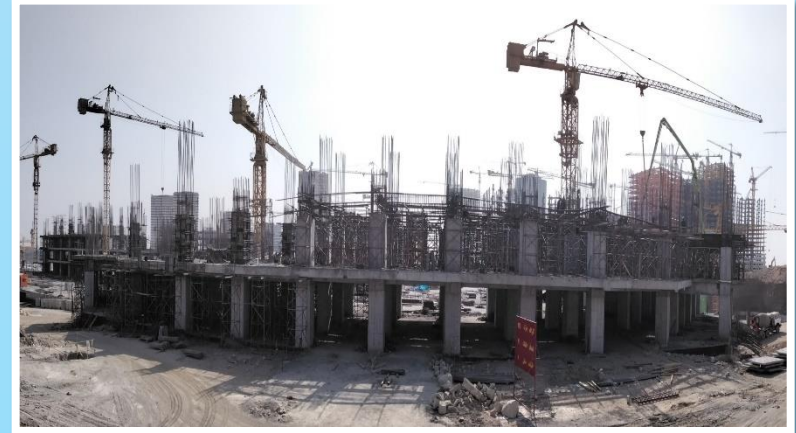
ضلع شمال مورخ ۱۴۰۱/۰۷/۳۰
