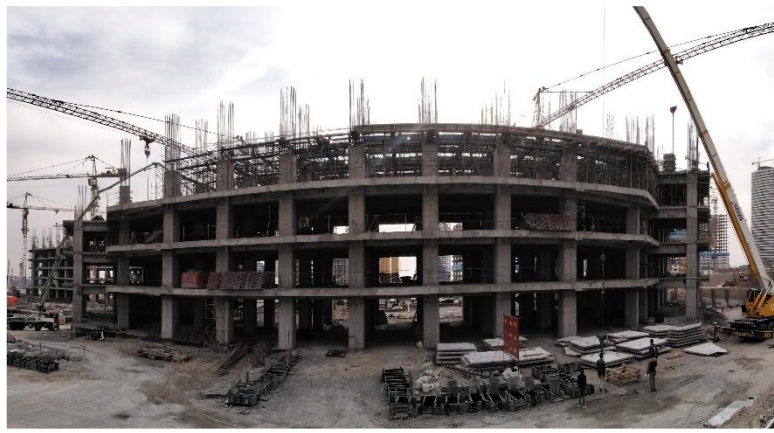
ضلع شمال مورخ ۱۴۰۱/۰۹/۳۰
