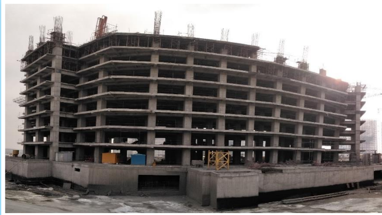
ضلع شمال مورخ ۱۴۰۱/۰۸/۳۰
