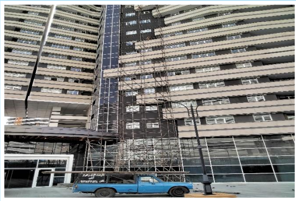
اجرای نصب داربست جهت نصب ورق کامپوزیت نمای ضلع شمالی
