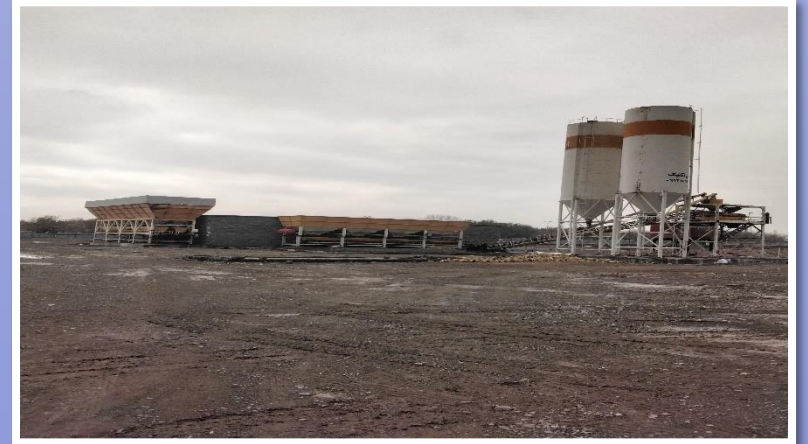
اجرای احداث بچینگ
