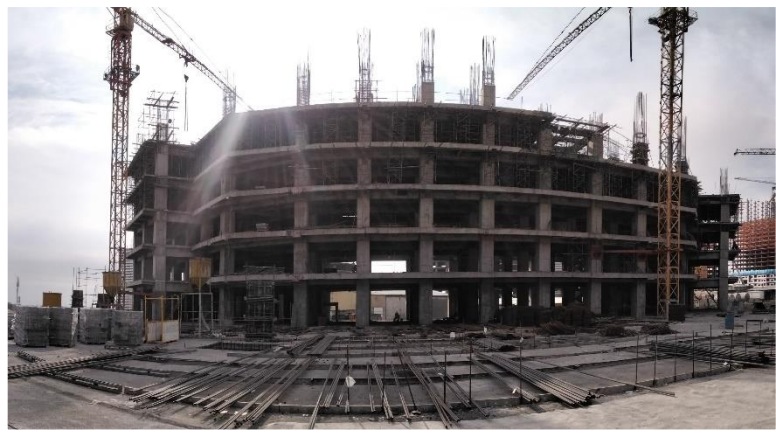
ضلع شمال مورخ ۱۴۰۱/۰۹/۳۰
