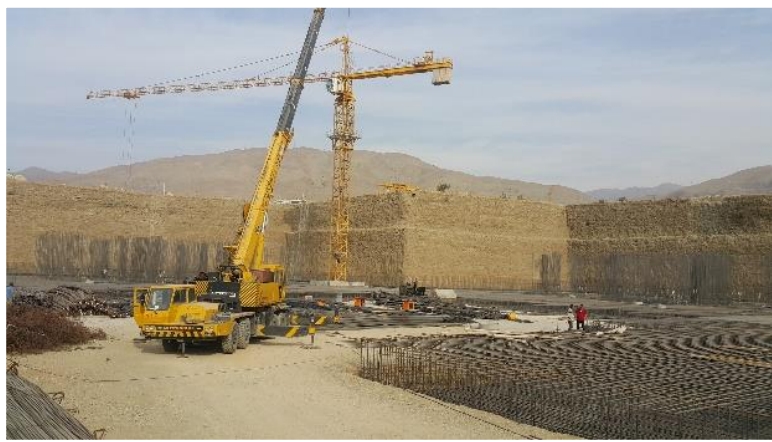
اجرای آرماتوربندی قطعه E
