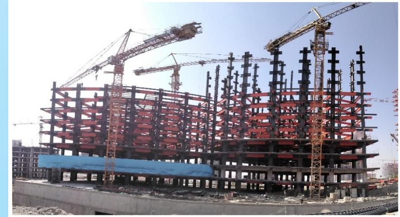
ضلع شمال مورخ ۱۴۰۱/۰۷/۰۱
