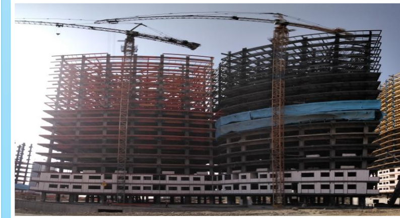
ضلع شمال مورخ ۱۴۰۱/۰۷/۳۰
