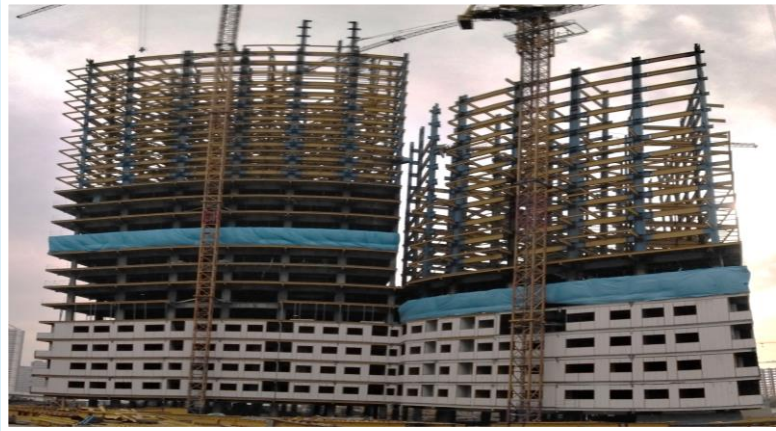
ضلع شمال مورخ ۱۴۰۱/۰۹/۰۱
