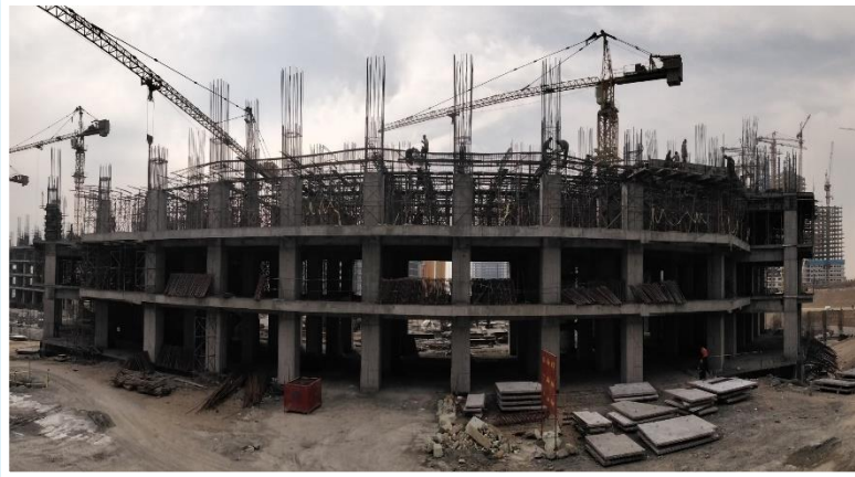
ضلع شمال مورخ ۱۴۰۱/۰۹/۰۱
