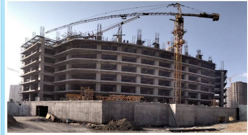
ضلع شمال مورخ ۱۴۰۱/۰۷/۰۱
