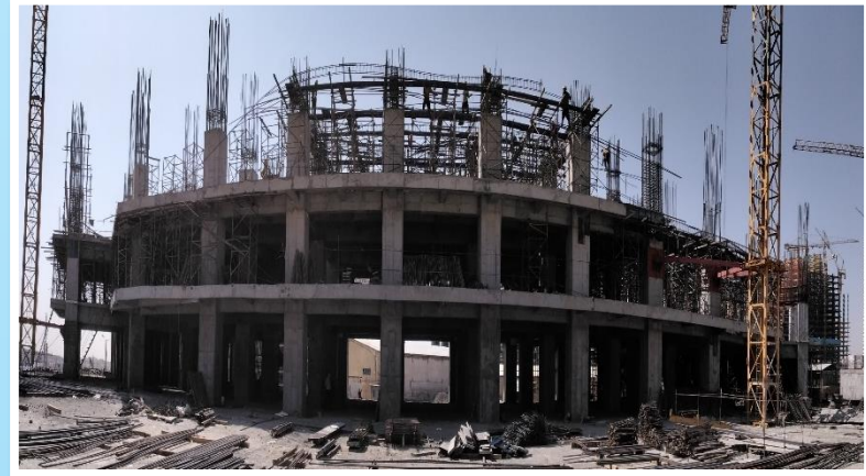
ضلع شمال مورخ ۱۴۰۱/۰۷/۰۱
