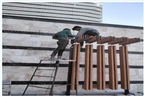
اجرای نصب پرگولا محوطه شمالی
