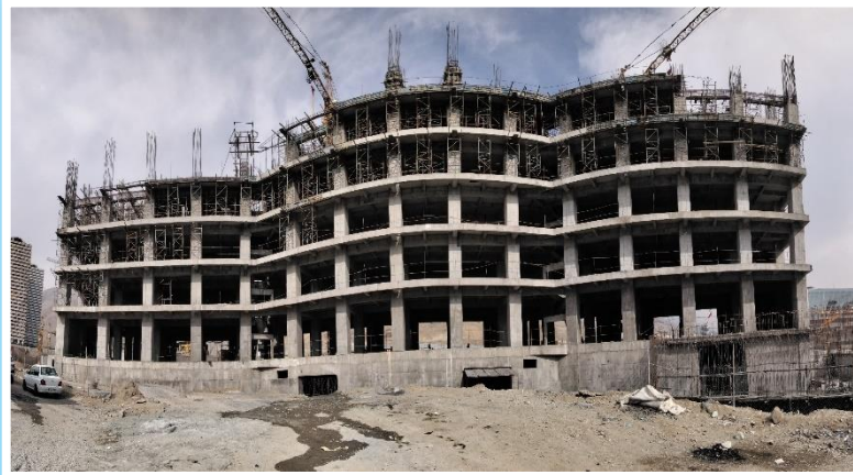
ضلع جنوب مورخ ۱۴۰۱/۰۹/۳۰
