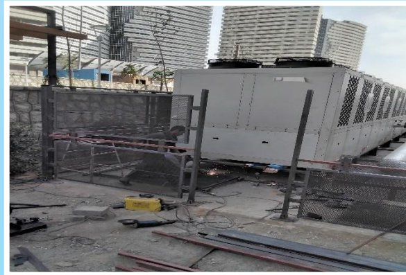
اجرای حفاظ پیرامونی چیلرها ضلع شمالی
