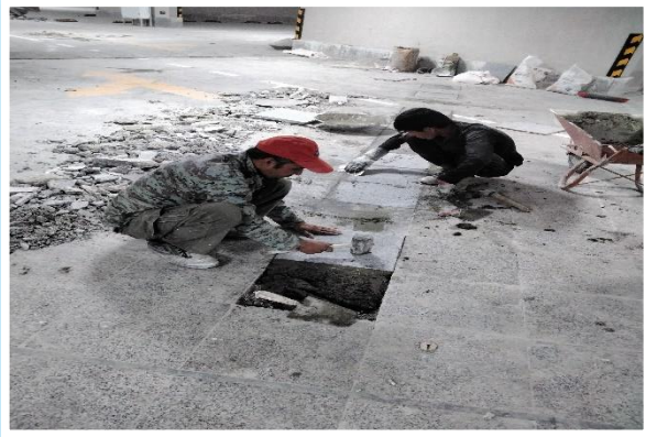
اجرای اصلاح سنگ کف پارکینگ منفی چهار
