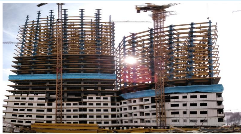
ضلع شمال مورخ ۱۴۰۱/۰۹/۳۰
