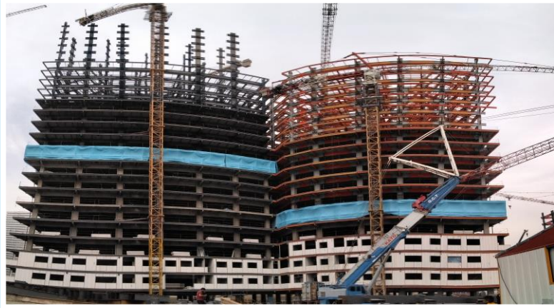
ضلع جنوب مورخ ۱۴۰۱/۰۹/۰۱
