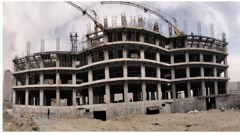
ضلع جنوب مورخ ۱۴۰۱/۰۹/۰۱
