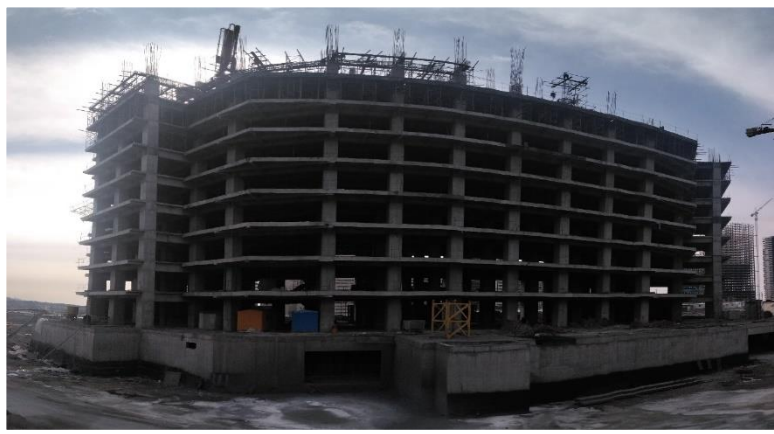
ضلع شمال مورخ ۱۴۰۱/۰۹/۳۰
