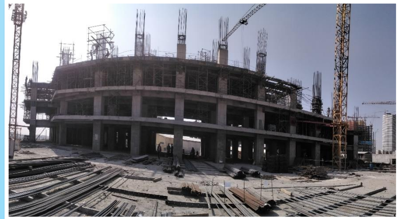
ضلع شمال مورخ ۱۴۰۱/۰۷/۳۰
