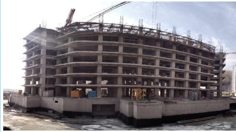
ضلع شمال مورخ ۱۴۰۱/۰۸/۰۱
