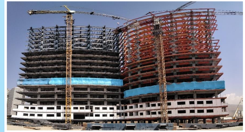
ضلع جنوب مورخ ۱۴۰۱/۰۷/۰۱
