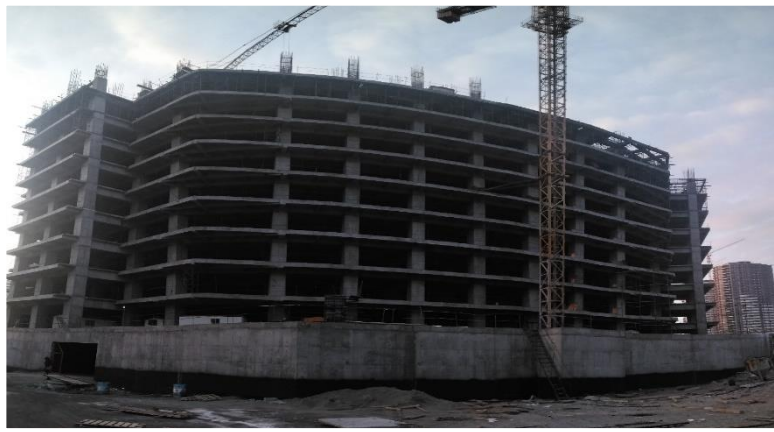
ضلع شمال مورخ ۱۴۰۱/۰۹/۳۰
