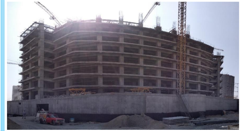
ضلع شمال مورخ ۱۴۰۱/۰۷/۳۰
