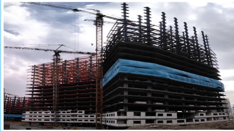
ضلع شمال مورخ ۱۴۰۱/۰۸/۳۰
