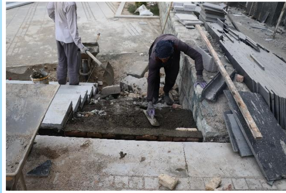
اجرای ساخت پله محوطه شمال غربی
